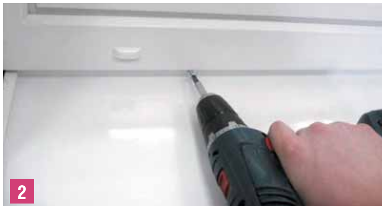
Установка отливов
