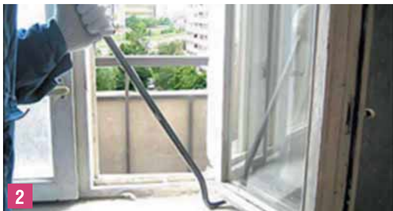
Освобождение старой оконной рамы
