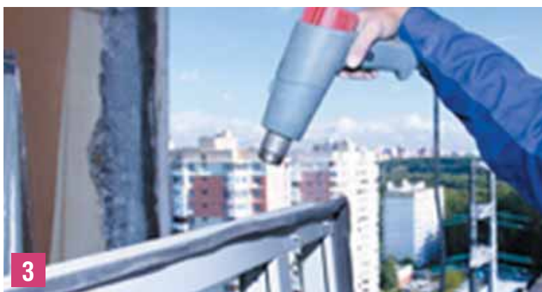
Установка герметизирующих лент
