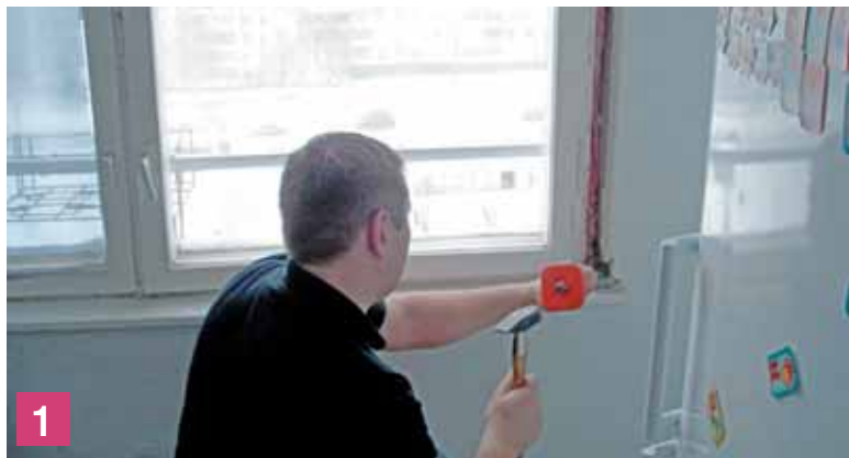
Демонтаж отливов и подоконников
