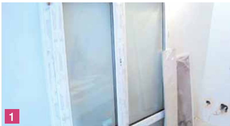
Расстекление глухих частей окна и снятие створок
